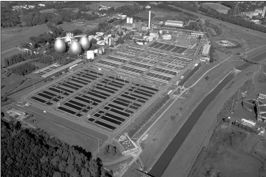
Abb. 2: Die unmittelbar an der Emscher gelegene Kläranlage Bottrop entstand im Zeitraum 1991 bis 1997 mit einem Investitionsvolumen von 230 Millionen Euro. Die Abwasserbehandlung von 1,3 Mio. Einwohnerwerten ist energieintensiv. Die Kläranlage ist aber zugleich ein Ort der Energieerzeugung. Das bei der Faulung des Klärschlammes entstehende Faulgas wird als Rohstoff für die Erdgas- und Wasserstoffproduktion genutzt oder in einem Blockheizkraftwerk verstromt.
