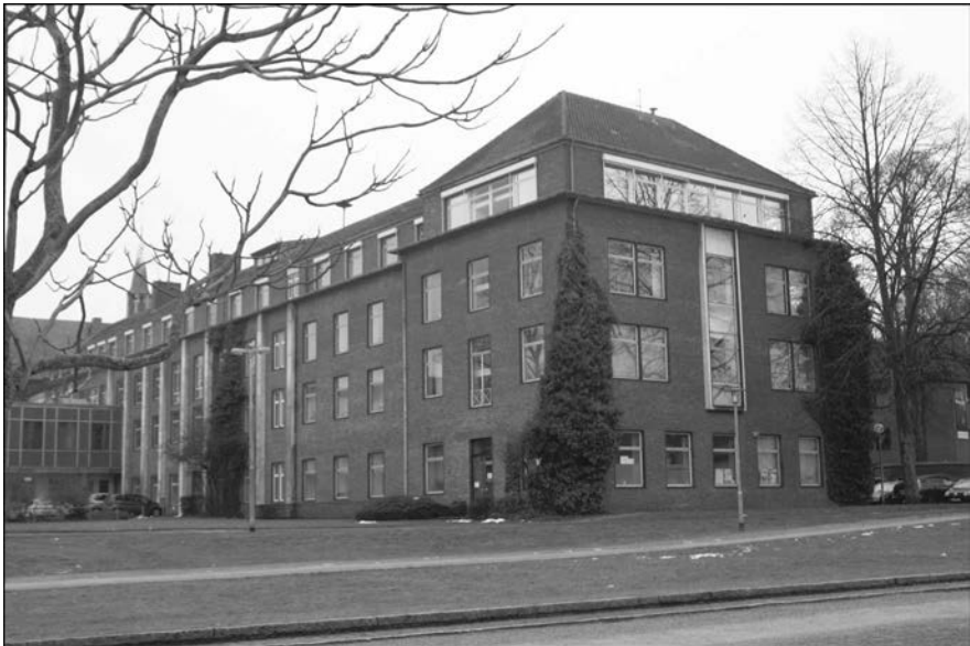
Foto 3: Das sanierungsbedürftige Rathaus in Kleve
