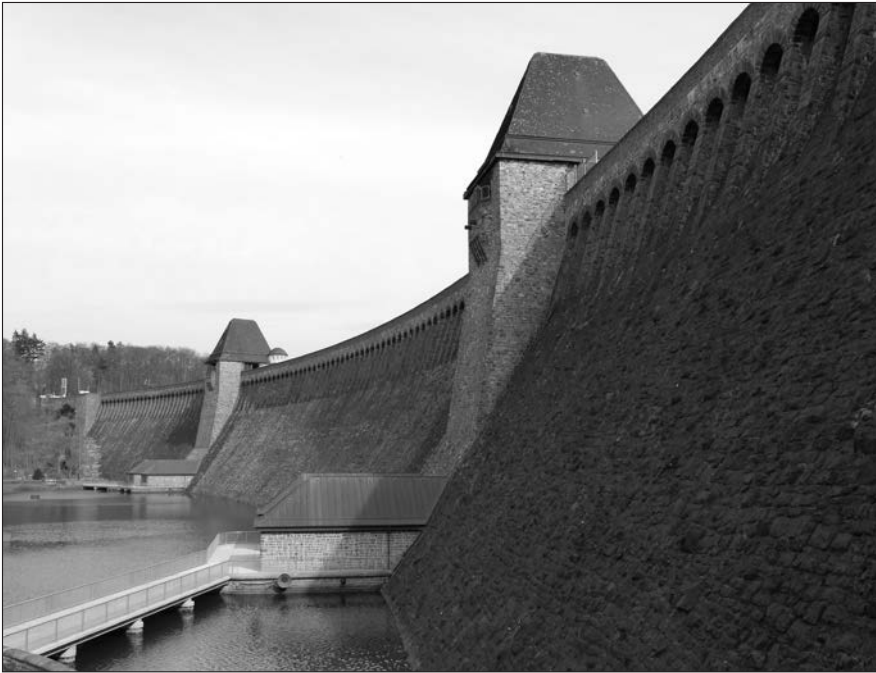
Abb. 2: Luftseite der Möhne-Staumauer heute. Das im Vordergrund sichtbare Wasser gehört zu einem Ausgleichsbecken unterhalb des Stausees.
