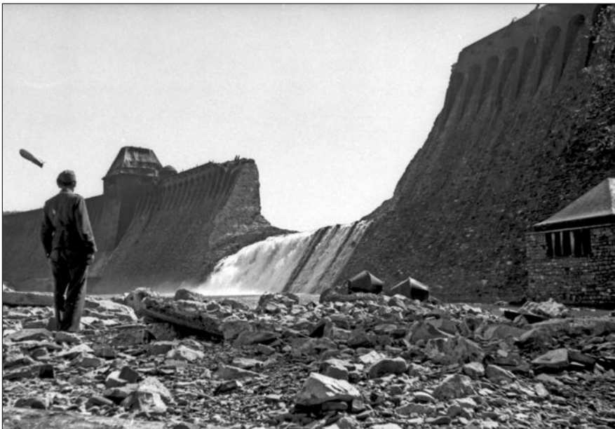
Abb. 4: Die zerstörte Möhne-Staumauer von der Luftseite her, 17. Mai 1943 (Bundesarchiv 101I-637-4192-23 / Schalber)
