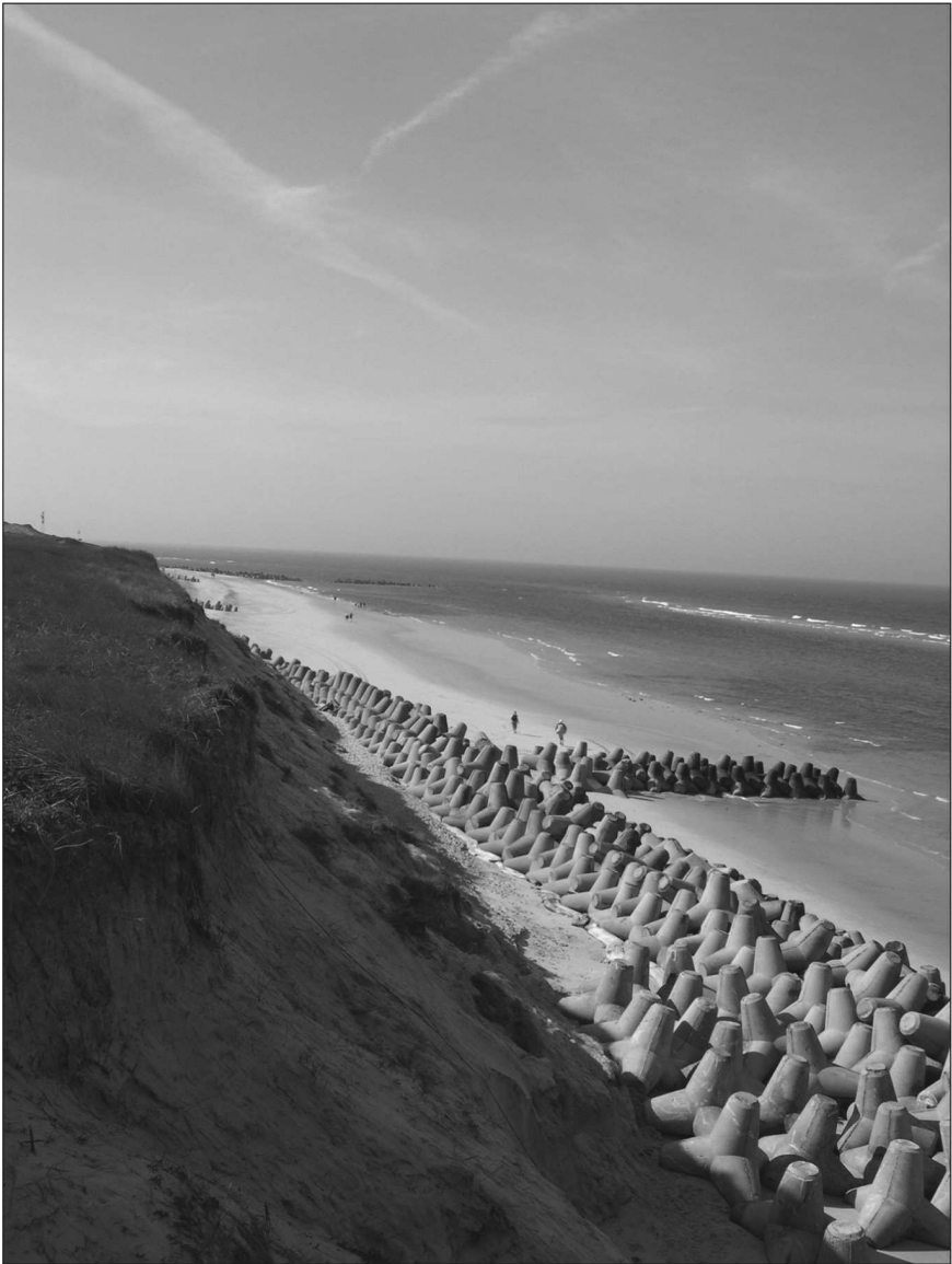
Foto 1: Lockermaterialküste auf Sylt mit Tetrapoden als Küstenschutzmaßnahme, durch die die Erosion entgegen der Zielsetzung zum Teil sogar verstärkt wurde. Quelle: mit freundlicher Genehmigung von KAI AHRENDT, Kiel.
